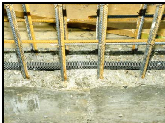
Waterstop fijada con malla DK-NET
