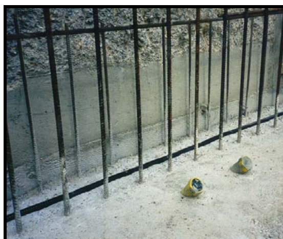
Waterstop en arranque de muro fijada con adhesivo
